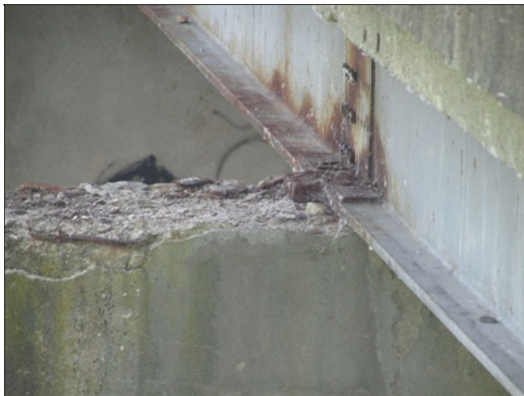
Uložení krajního nosníku na P2 vlevo
