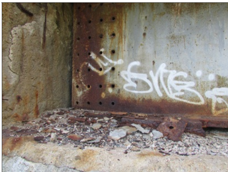
Uložení krajního nosníku na OP3 vlevo
