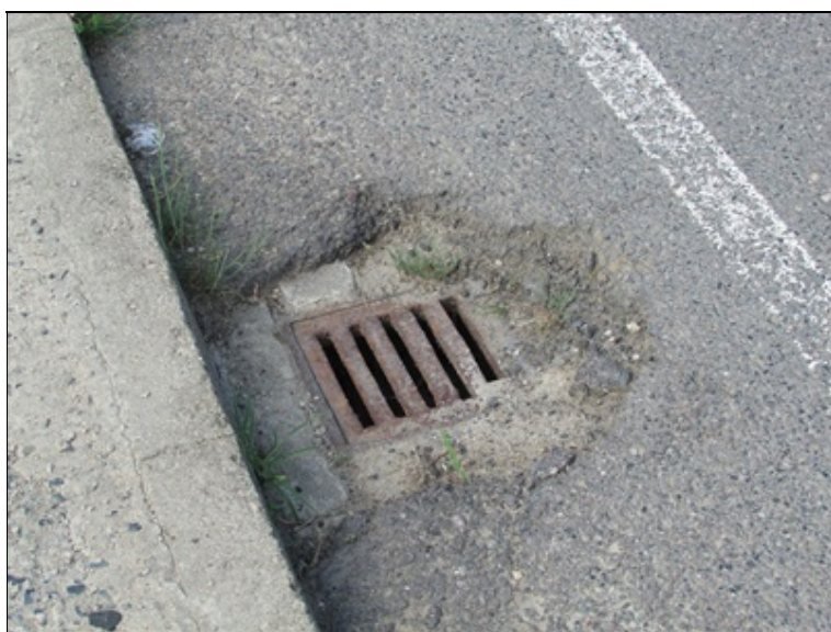
Detail odvodňovače - vegetace a převrstvená vozovka
