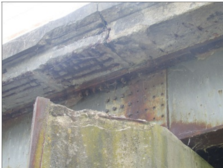
Degradace deský NK nad pilířem
