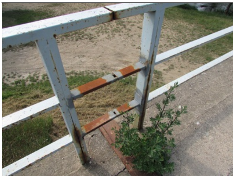
Zábradlí po lokální opravě
