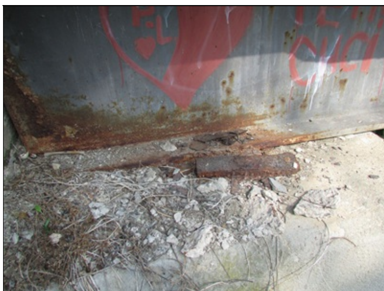
Uložení krajního nosníku na OP1 vpravo - utržené boční vedení
