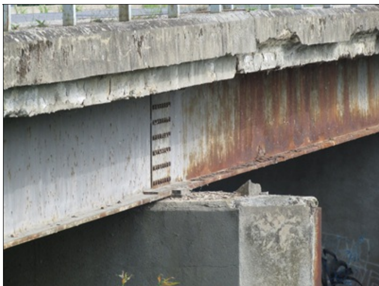
Uložení krajního nosníku na P2
