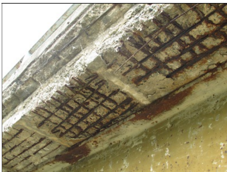
Degradace deský NK v poli 3 vpravo
