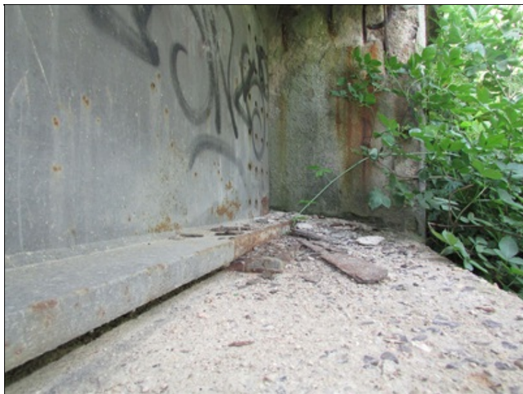
Uložení krajního nosníku na OP1 vlevo- utržené boční vedení
