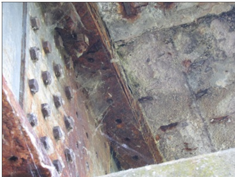
Podhled desky NK - nad piliřem - koroze HP OK
