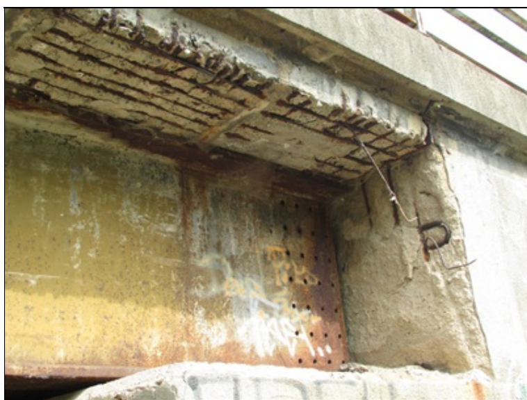
Uložení krajního nosníku na OP3 vpravo - degradace desky NK
