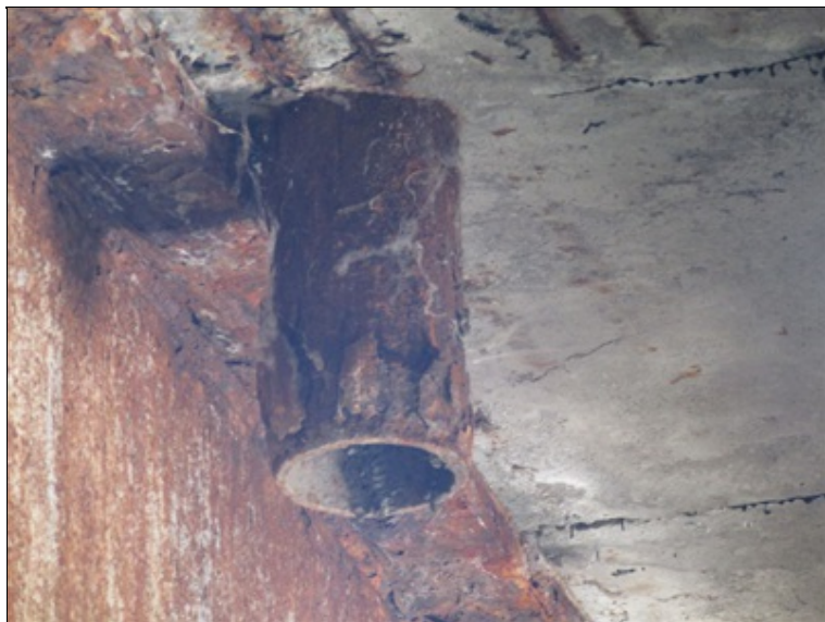
Koroze svodu odvodňovače
