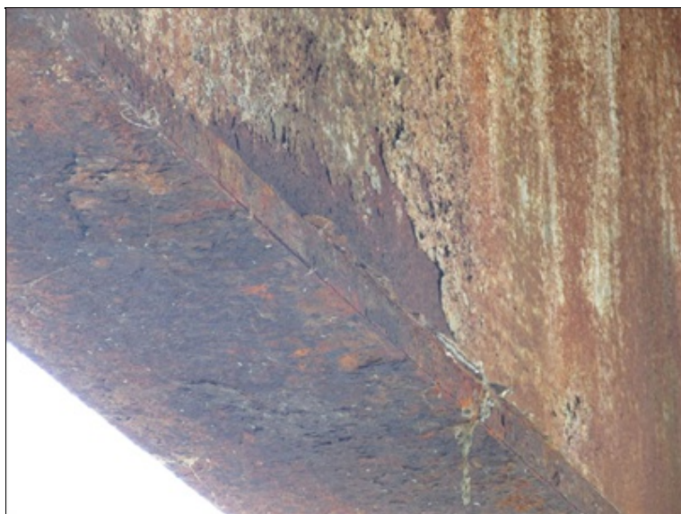
Koroze dolní pásnice HN v místě odvodňovače v poli 2 - levý kraní nosník
