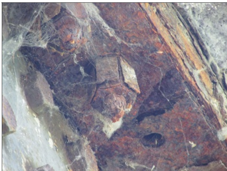
Detail koroze v místě přiložky HP OK - nad piliřem
